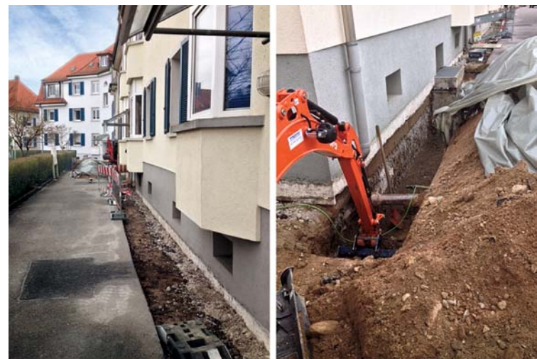
Eine Instandhaltungsmaßnahme in 2014 war unter anderem die Abdichtung und nachträgliche Dämmung der Kelleraußenwände der Gebäude Carl-Schurz-Straße 9 und 11
